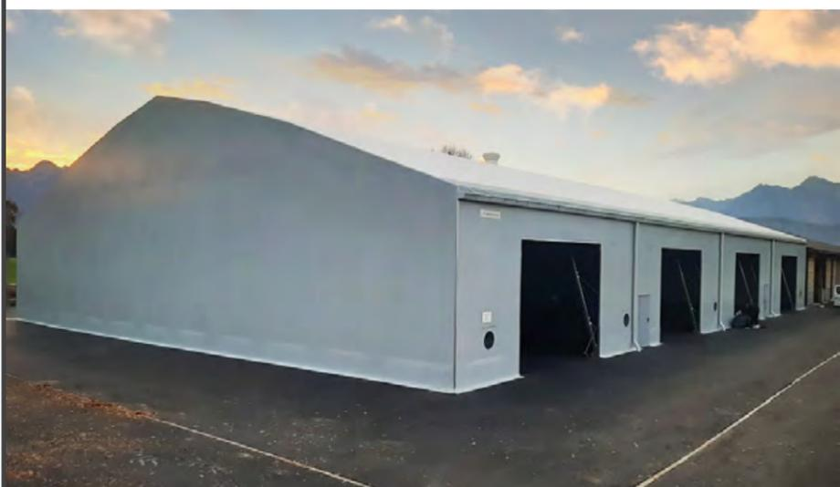
Die Lager-Zelthalle mit den Abmessungen 30 × 44,5 × 4,5 m wurde Ende letzten Jahres im österreichischen Rankweil errichtet. Die Pümpel GmbH besitzt an diesem Standort ein großes Außenlager, das es zu vergrößern galt. Die Zelthalle, die auf der vorhandenen Asphaltfläche errichtet wurde, bietet über 1.300 m<sup>2</sup> zusätzliche Lagerfläche.
